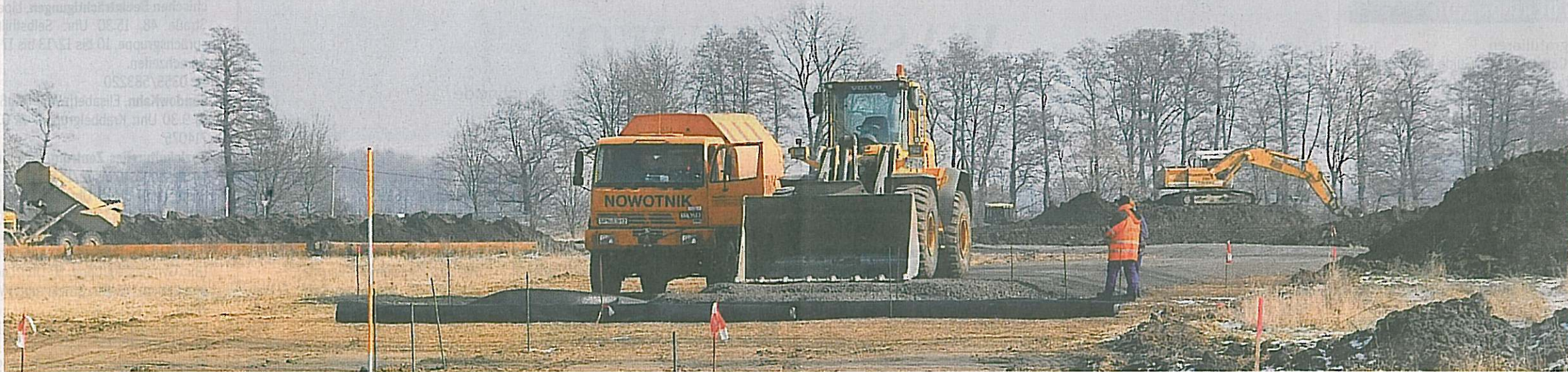
Zwischen Striesow und Fehrow hat der Bau des neuen Deiches begonnen. Es ist der letzte Abschnitt der Spree-Renaturierung, die voraussichtlich 2013 abgeschlossen wird.
